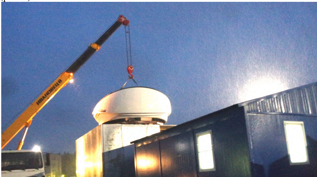
Рис. 7. Монтаж купола ЛС КСФО
