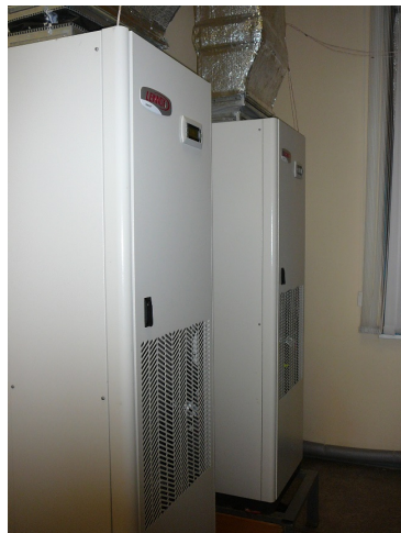
Рис. 3. Оборудование системы прецизионного кондиционирования
