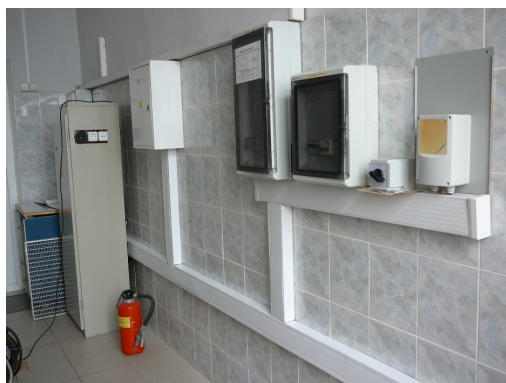
Рис. 3. Оборудование системы прецизионного кондиционирования
