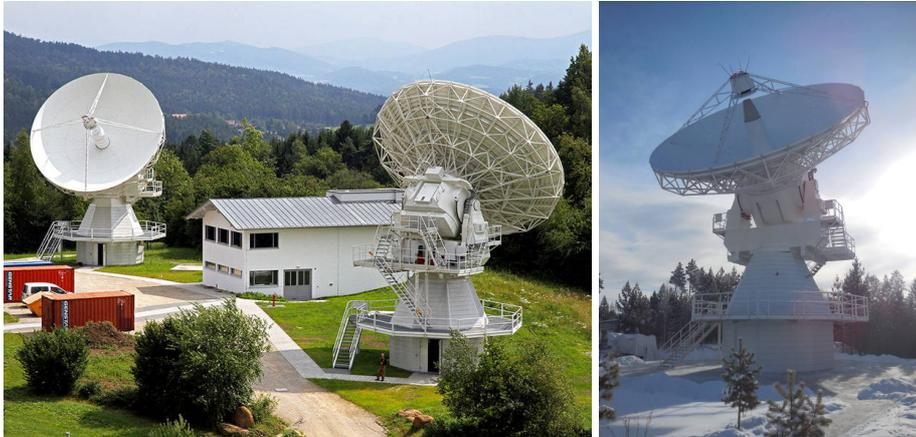
Рис. 29. Быстровращающиеся антенны малого диаметра обсерватории Ветцель ([www.tum.de](http://www.tum.de), Германия, слева) и двухэлементного радиоинтерферометра на узлах колокации ([www.ipa.nw.ru](http://www.ipa.nw.ru), справа)
